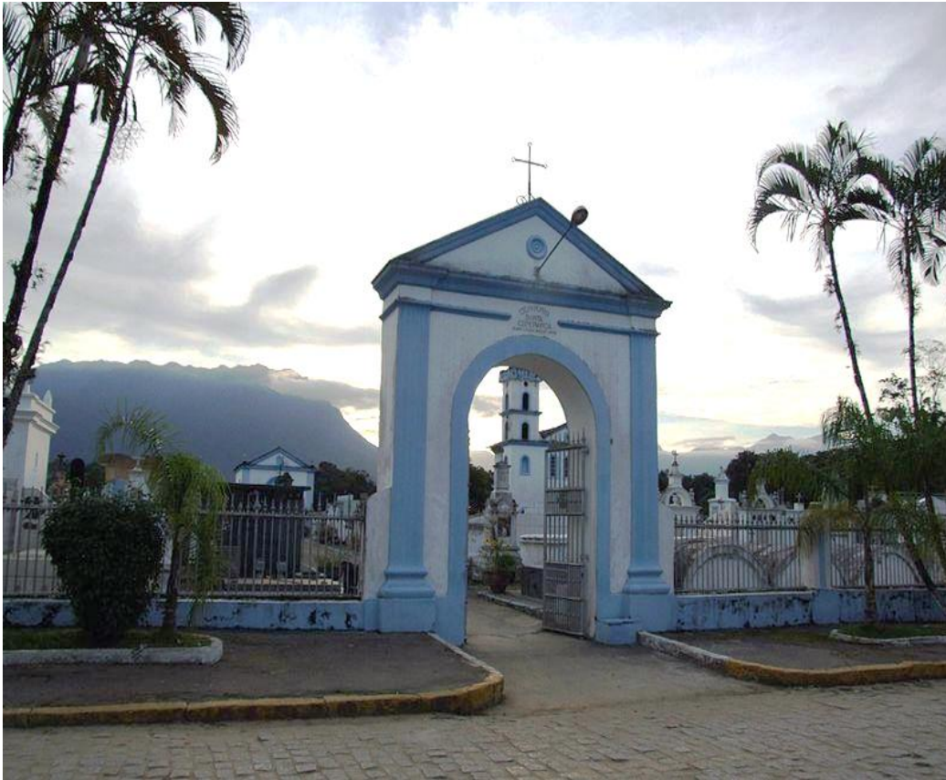
Figura 40 - Entrada do Cemitério Santa Esperança.
