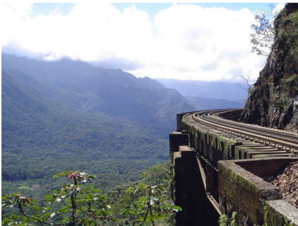
FIGURA 9.3.15.1 – ESTRADA DE FERRO – VISTA LINHA FÉRREA
