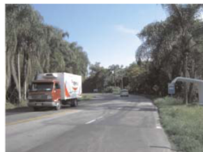
Trecho da Rodovia PR-408
