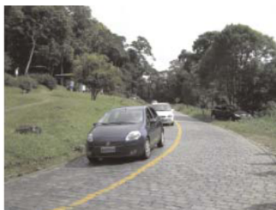
Trecho da Rodovia PR-410
