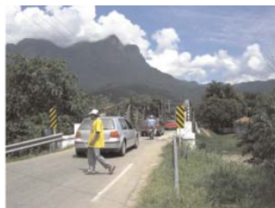
Trecho da Rodovia PR-411
