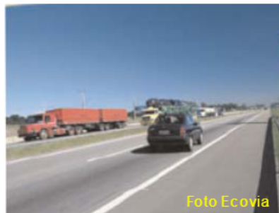
Trecho da Rodovia BR-277
