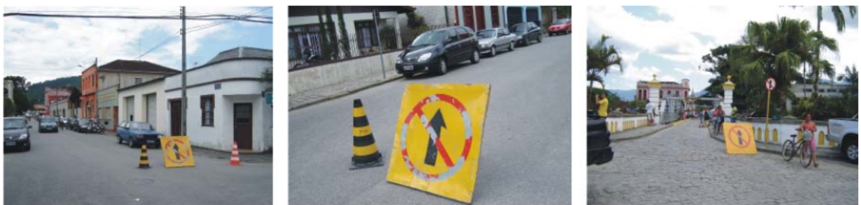
FIGURA 7.8.4.1 – INDICAÇÃO TEMPORÁRIA DE PROIBIÇÃO DE TRÁFEGO
