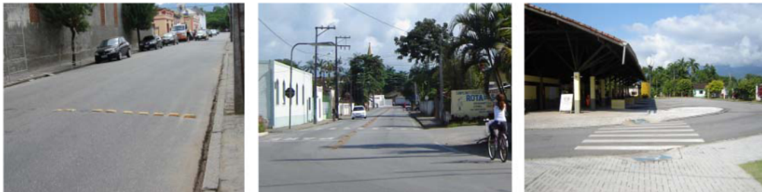
FIGURA 7.8.7.2 – ASPECTOS DA SINALIZAÇÃO HORIZONTAL NA ÁREA URBANA
