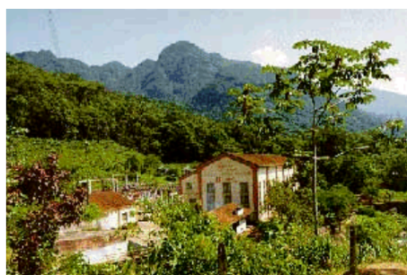
FIGURA 7.2.4.1 – USINA HIDRELÉTRICA MARUMBI
