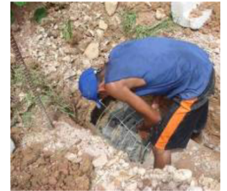
Obras de Drenagem na Vila Ferroviária, no Distrito Sede
